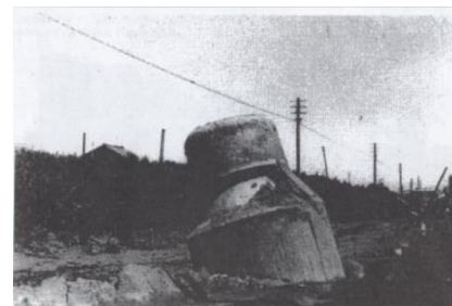
شکل ۹ نشست دریچه بازدید به علت روانگرایی
