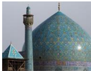
شکل ۹ نمای بیرون گنبد مسجد جامع عباسی.
