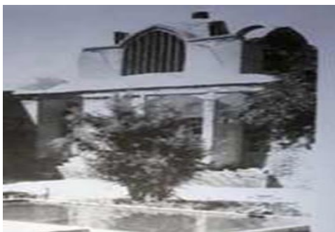
شکل ۶ بادگیر سه طرفه در سیرجان - بادگیر شاهکار مهندسی ایران - ۲۴۵
