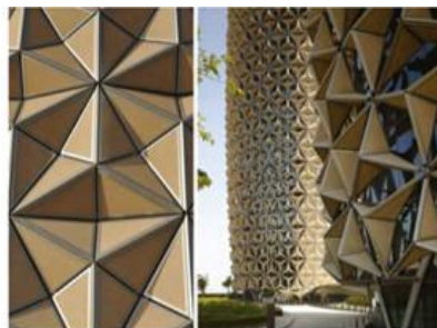
شکل ۳ برج های دو قلوی البحر، ابوظبی. الگوی نمای متحرک.
